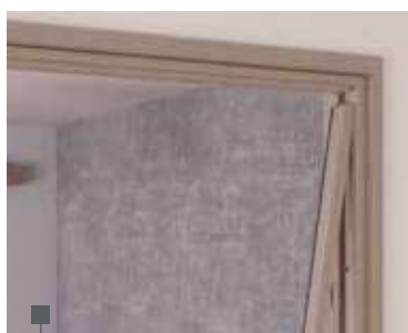
Système de feuillure amovible permettant un vissage invisible.
