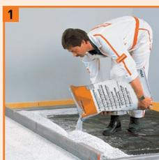
1 Assurez-vous que le sol soit porteur et plan. Dans le cas d'irrégularités, utiliser les granules d'égalisation FERMACELL. Au préalable, appliquer un feutre sur plancher bois ou un polyane sur dalle béton.
