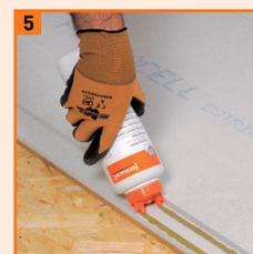
5 Appliquer la colle en deux cordons sur la battue inférieure d'une plaque avant de la recouvrir par la battue supérieure de la plaque suivante.
