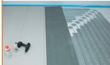
Consommation : colle FERMACELL bouteille de 1 kg pour 25 m<sup>2</sup>, vis FERMACELL (3,9 x 22 mm) : env. 15 vis/m<sup>2</sup> et enduit FERMACELL : env. 100 g/m<sup>2</sup>.
