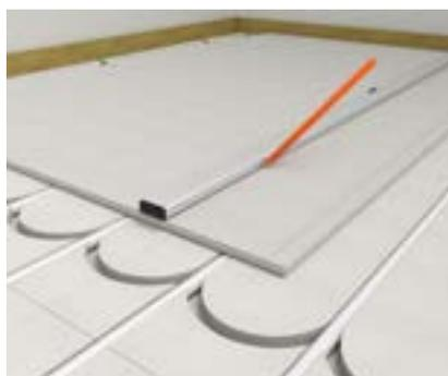
Pour la fixation par vis (vis pour plaque de sol fermacell®) ou par agrafe, effectuer un repérage des lignes de fixations.
