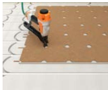
Il suffit ensuite de visser ou d'agrafer, en suivant les perforations du gabarit spécialement conçu à cet effet.
